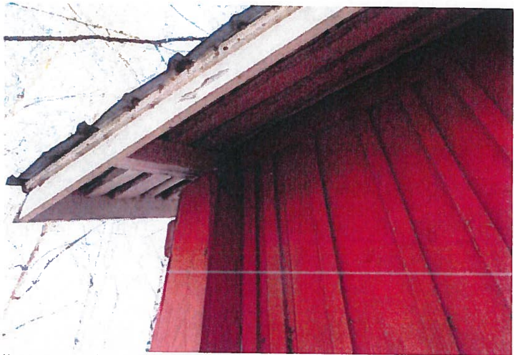
Kuva 4. Päärakennuksessa on sopivia aukkoja liito-oravalle, joista eläin pääsee helposti rakennuksen ullakolle.
