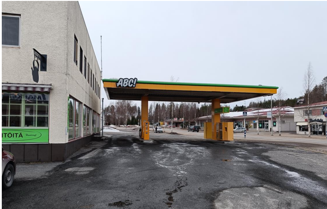
Kuva 3. Nykyinen polttoaineen jakeluasema
